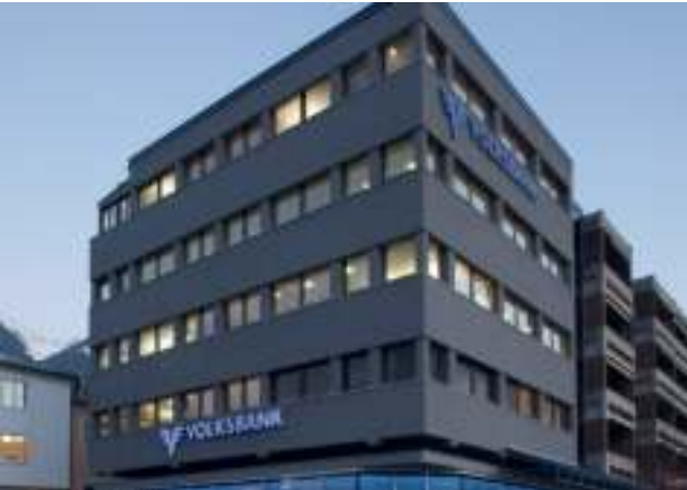
Hauptgeschäftsstelle Schwaz Josef-Wopfner-Straße 8, 6130 Schwaz
