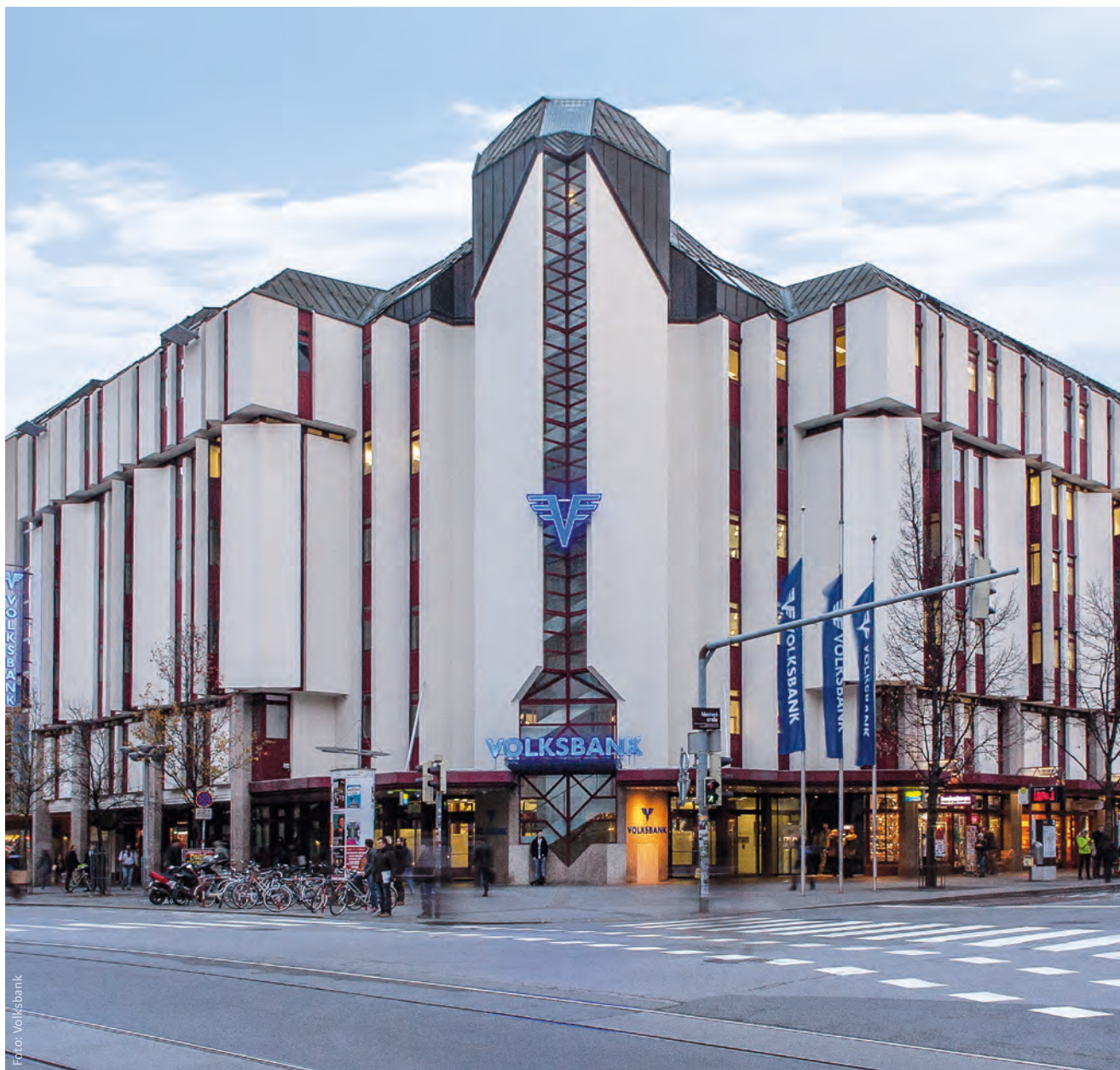
Im Juni 1986 wurde die neue Hauptanstalt in der Meinhardstraße 1 eröffnet. Heute befindet sich dort die Hauptgeschäftsstelle Innsbruck der Volksbank Tirol.
